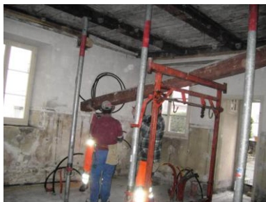
Renforcement du plafond
