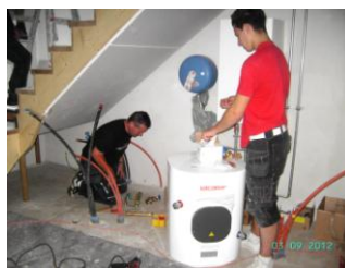
pompe à chaleur...
